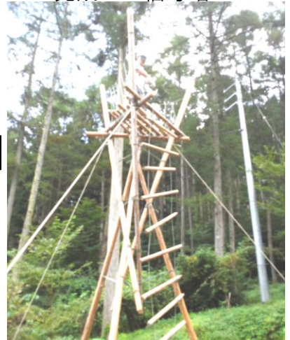
完成した信号塔
